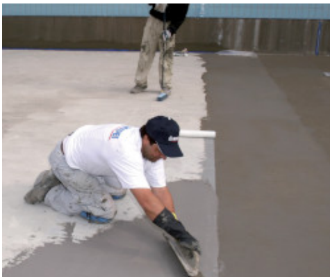
Tesnjenje bazena z Mapelastic-om Zero
