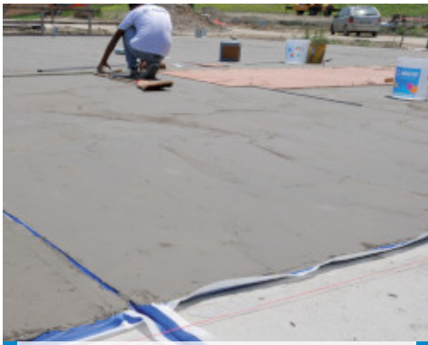
Izvedba tesnjenja cementnega tlaka z Mapelastic-om Zero in Mapeband-om
