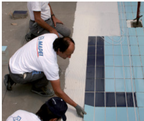
Polaganje keramike na Mapelastic Zero v bazenu
