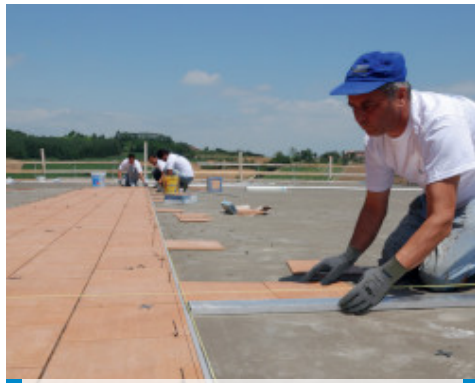
Polaganje keramičnih ploščic s Kerabond-om + Isolastic
