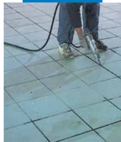
Zapolnitev dilatacijske rege v talni oblogi iz keramičnih ploščic z Mapesil-om AC
