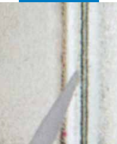
Tesnjenje steklenih U elementov
