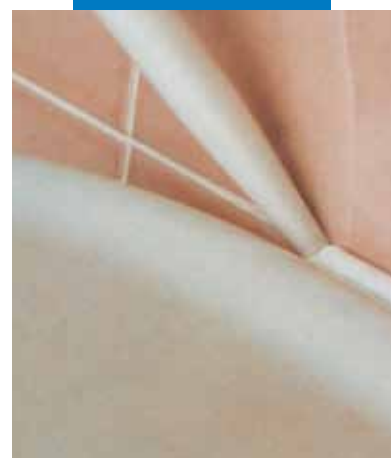
Tesnjenje sanitarne opreme
