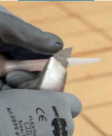
Rezanje tulca na zahtevano širino fuge
