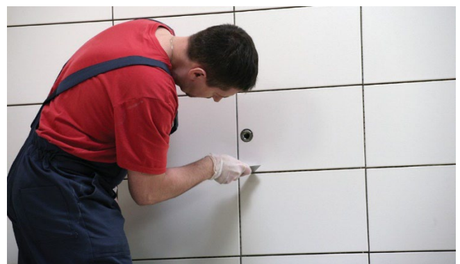
Čiščenje robov ploščic pred fugiranjem
