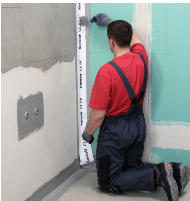
Lepljenje tesnilnega traku v vertikalnih kotih.
