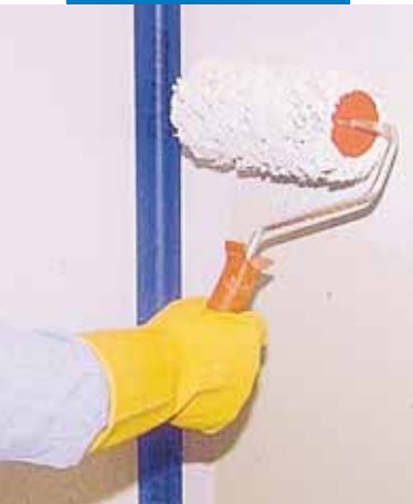
Nanašanje Mapegum-a WPS na stene z valjčkom
