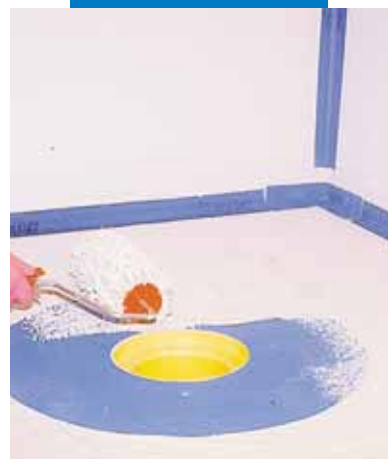
Prekrivanje tesnilne manšete Mapeband z Mapegum-om WPS
