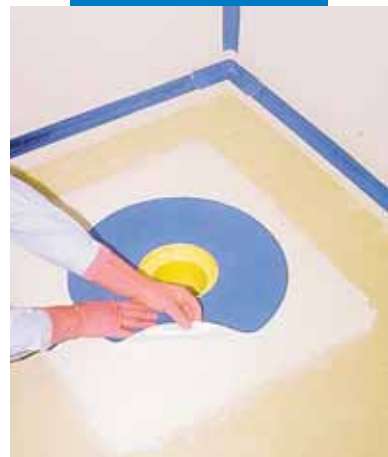
Postavljanje tesnilne manšete Mapeband na sveži Mapegum WPS
