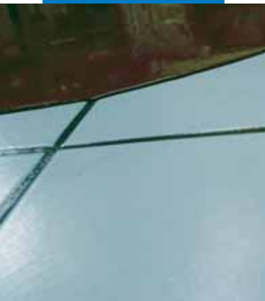
Prikaz nanosa Ultraplan -a na obstoječi tlak iz keramičnih ploščic, ki je predhodno obdelan z Mapeprim -om SP
