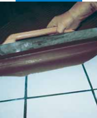
Nanašanje Ultraplan -a s kovinsko gladilko na obstoječi tlak iz keramičnih ploščic, ki je predhodno obdelan z Mapeprim -om SP
