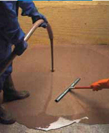
Strojno nanašanje Ultraplan -a s transportno črpalko in razprostiranje z lopatico za mase
