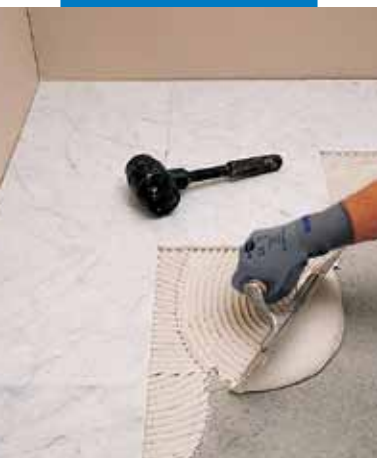
Lepljenje belega marmorja Carrara z belim lepilom Keraquick
