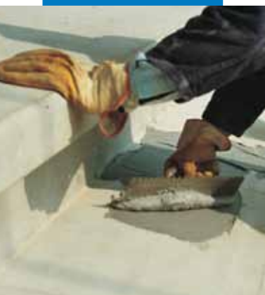
Nanašanje Adesilex-a PG1 z zobato lopatico za konstrukcijsko zlepljenje prefabriciranih stopnic
