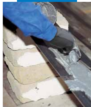
Nanos Adesilex-a PG1 na jekleno lamelo
