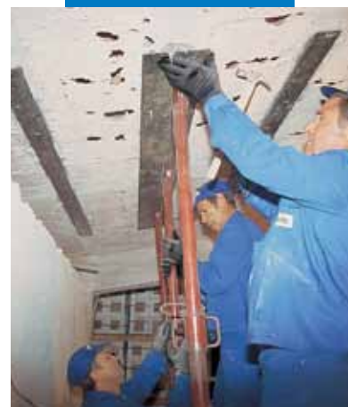
Izvedba konstrukcijske ojačitve stropa z jeklenimi lamelami
