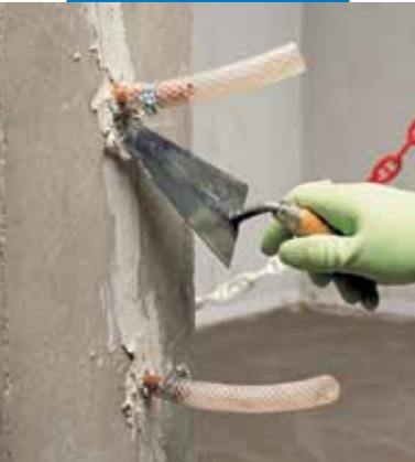
Pričvrstitev cevk za injektiranje in površinska zapolnitev razpok pri konstrukcijski obnovi
