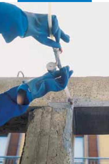
Obnovljen stik stebra in nosilca z Adesilex-om PG1
