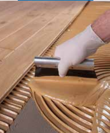
Razprostiranje lepila Ultrabond P990 1K
