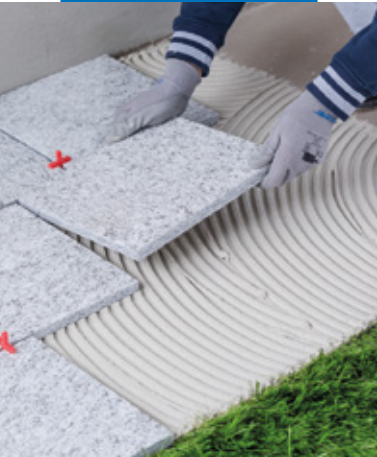
Polaganje naravnega kamna na zunanjih površinah
