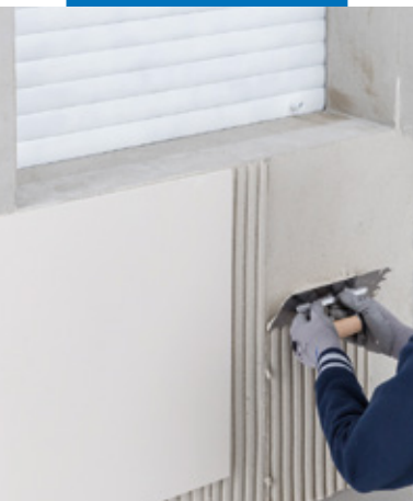
Polaganje keramičnih ploščic velikega formata
