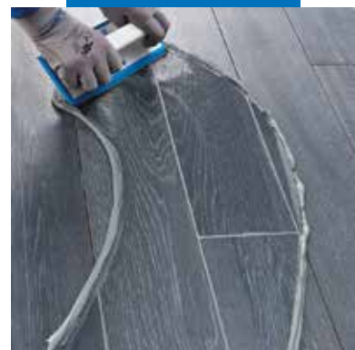
Vtiranje Kerapoxy-ja Design z gumirano lopatico v rege zaključne obloge iz ploščic porcelaniziranega gresa v imitaciji lesa
