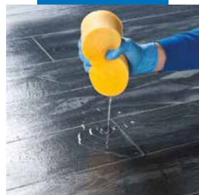
Omočenje zafugirane površine pred čiščenjem
