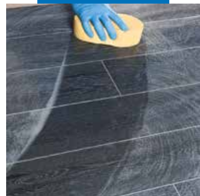
Zaključno čiščenje in zaključna obdelava fug s čvrsto celulozno gobo
