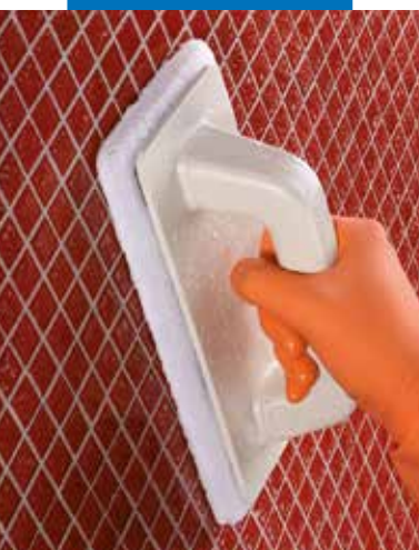
Čiščenje zafugirane površine steklenega mozaika s čistilnim filcem Scotch Brite®
