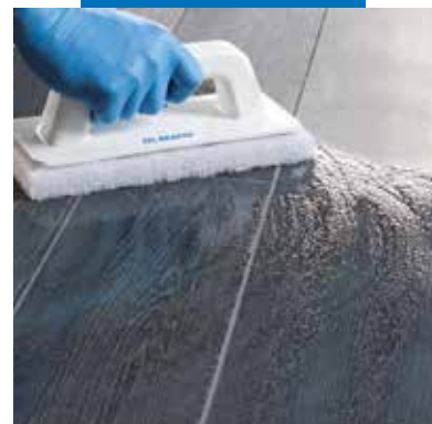
Čiščenje zafugirane površine s čistilnim filcem Scotch-Brite
