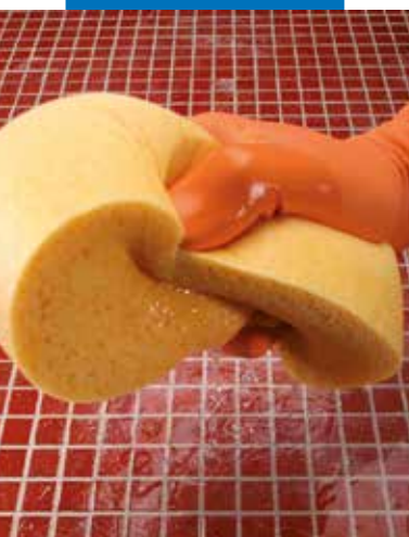
Omočenje zafugirane površine pred zaključnim čiščenjem
